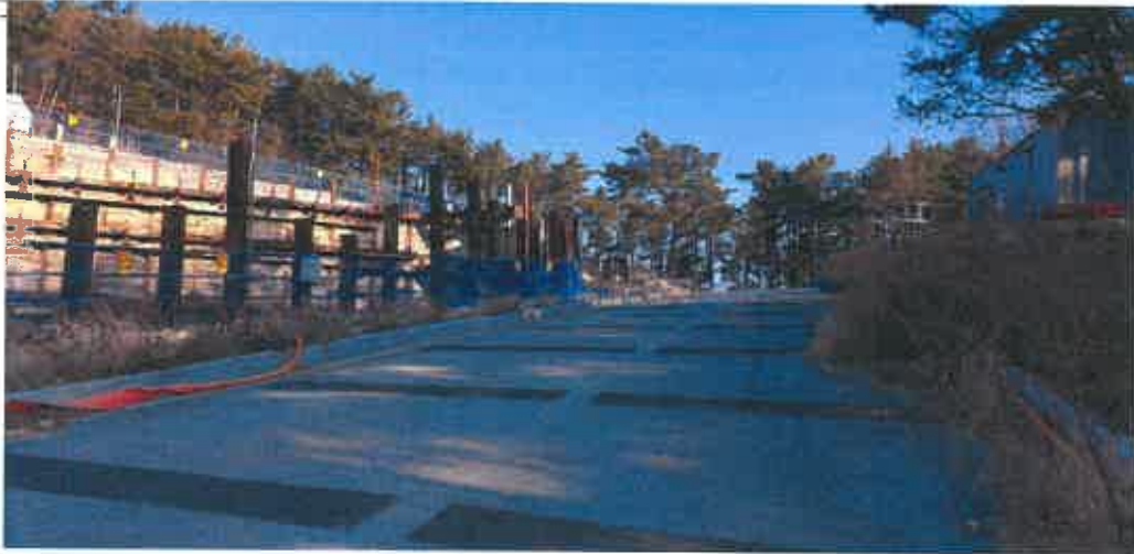
민원인 소유 부지(공주시 반포면 학봉리 879번지) 앞 진출입구 차단
